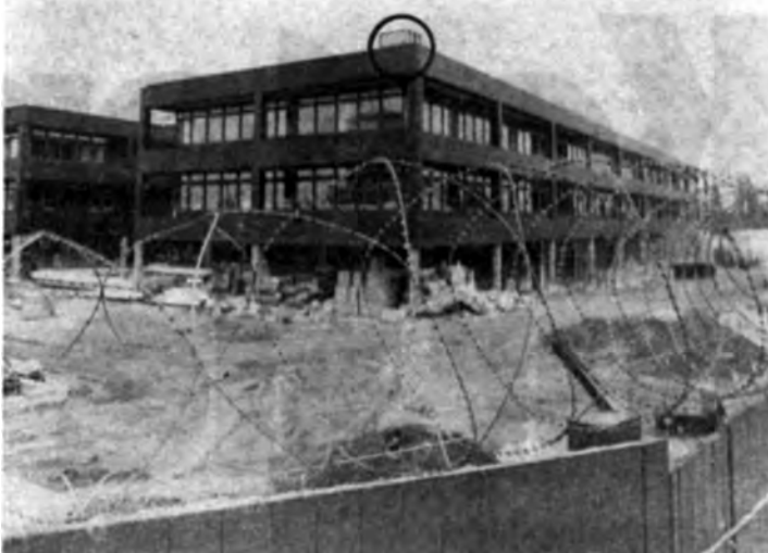
Abb. 83 Wachposten auf dem Dach des Bundeskanzleramtes während der Bauphase. Im Foto ist seine Plattform eingekringelt. Aufnahme Oktober 1975.
