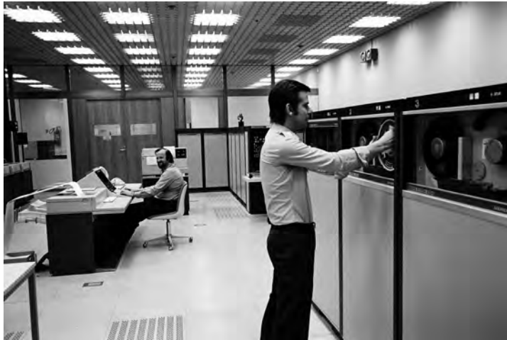
Abb. 76 Rechenzentrum des Presse- und Informationsamtes im Untergeschoss des Bundeskanzleramtes. Aufnahme 13.7.1977.
