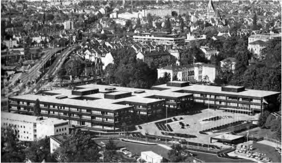
Abb. 88 Bundeskanzleramt, Blick vom Abgeordnetenhochhaus nach Westen.
