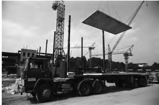
Abb. 40 Vorgefertigte Geschossplatten aus Beton ...
