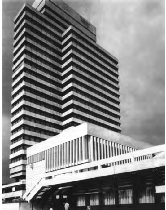
Abb. 66 Roland Ostertag: Rathaus Kaiserslautern (1963–68). Hochhausturm mit flachem Ratsaal aus Betonfertigteilen.
