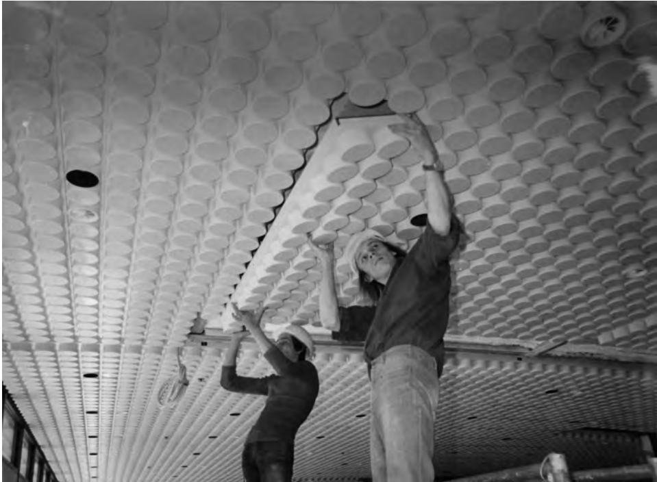
Abb. 85 Robert Latzel: Letzte Handgriffe bei den Innenausbauten. Aufnahme 1976.
