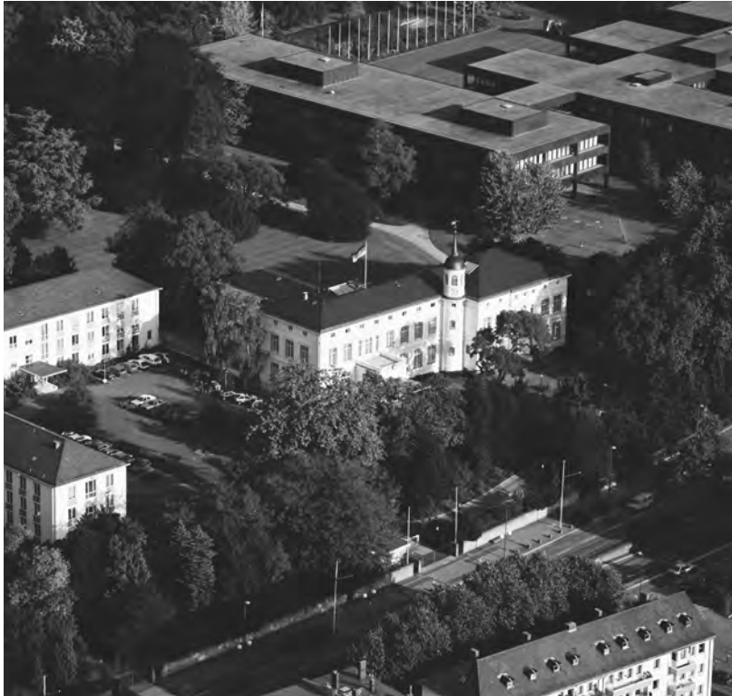
Abb. 8 Die Häuser II und III links, mittig Palais Schaumburg, rechts oben Neubau Bundeskanzleramt. Aufnahme 14.10.1991.
