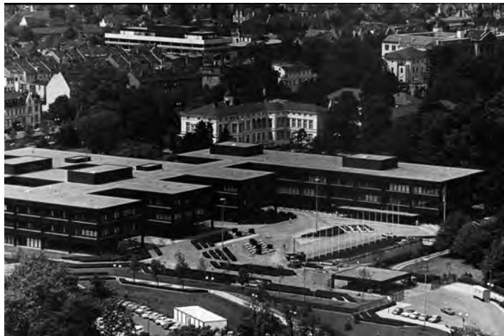
Abb. 44 Erste Vorplatzgestaltung aus Rotklinker, Betonelementen und niedrigem Taxus (bis 1979). Aufnahme 7.10.1976.
