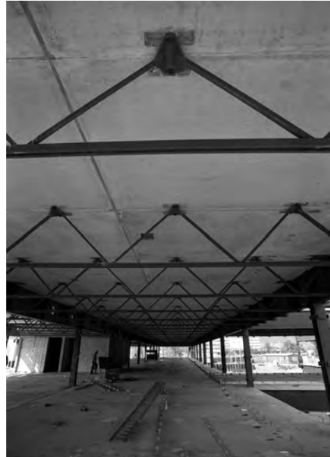
Abb. 69 Unter den Geschossdecken ist Raum für voluminöse Versorgungstechnik. Aufnahme 30.7.1974.
