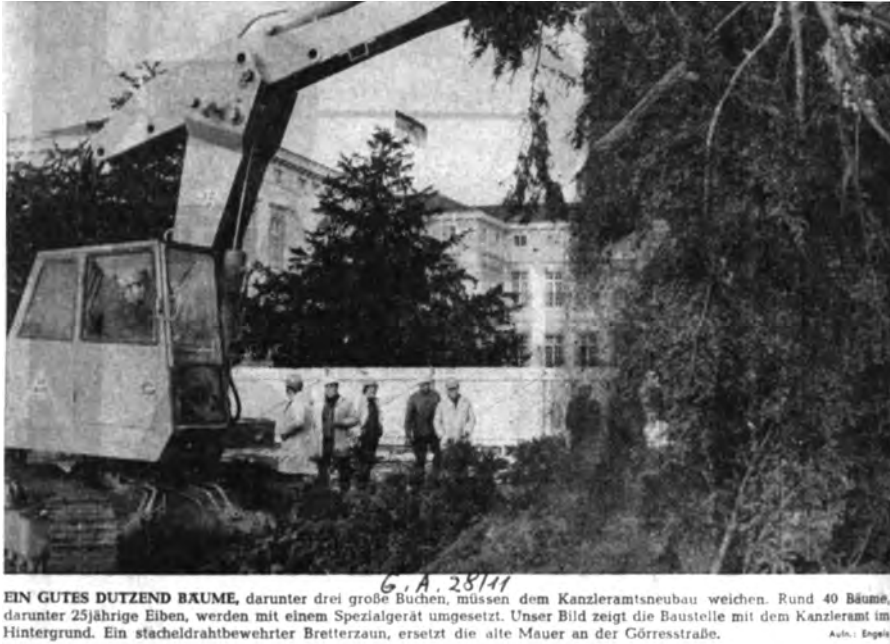
Abb. 71 Anlässlich des Spatenstichs werden Bäume auf dem Bauplatz niedergelegt.
