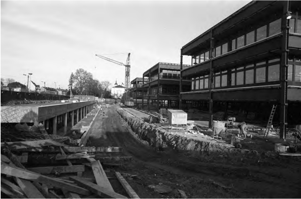
Abb. 38 Stahlkonstruktion aus Doppel-T-Stützen. Nach ihrer Verkleidung erreichten die Stützen gut doppelten Durchmesser. Links der Rohbau für den BGS. Hinten ist das weiße Palais Schaumburg zu erkennen. Aufnahme 21.1.1975.
