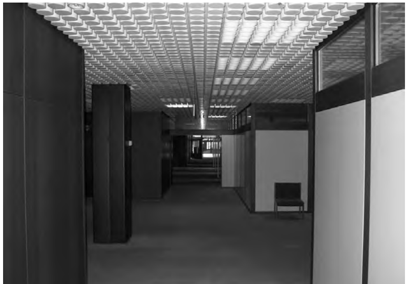
Abb. 54 Abteilungsbau Obergeschosse, Flurbereich. Aufnahme 2001, nahezu bauzeitlicher Zustand
