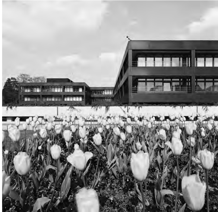
Abb. 82 Überwachungskamera auf dem Dach. Aufnahme 28.4.1977.
