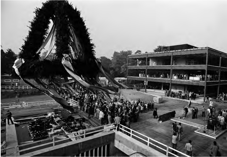
Abb. 95 Richtfest Bundeskanzleramt am 15.10.1974. Rechts im Bild der Kanzlerflügel.
