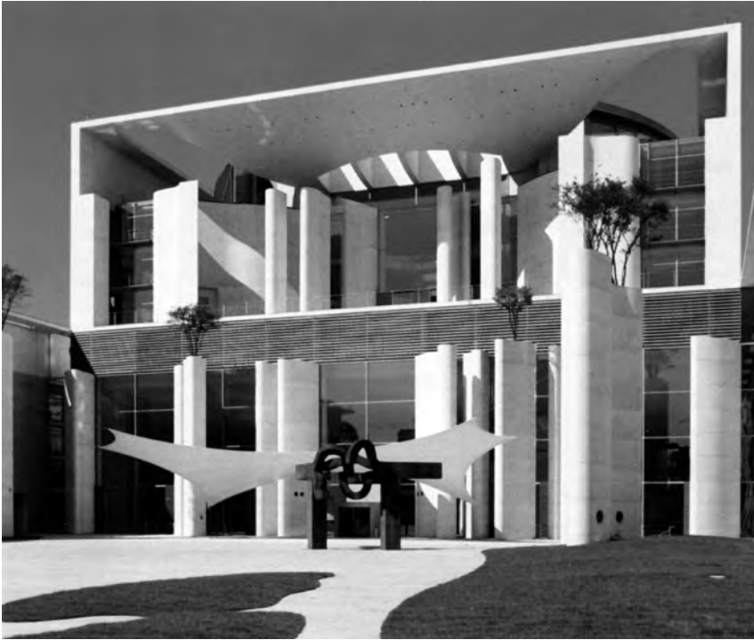
Abb. 115 Axel Schultes und Charlotte Frank: Bundeskanzleramt Berlin (1999–2001), Hauptfassade.
